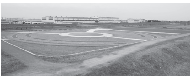
広場の工事が行われています
