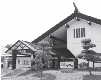
屋根を改修予定のなの花温泉田田
