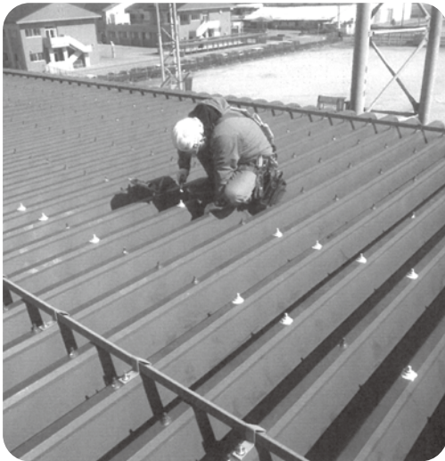
屋根の修理が行われる町民体育館
