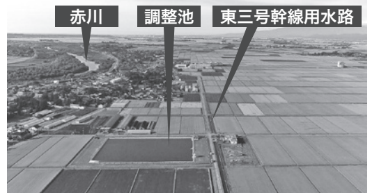
▲押切新田付近の空撮写真 (東北農政局赤川農業水利事業所提供)
