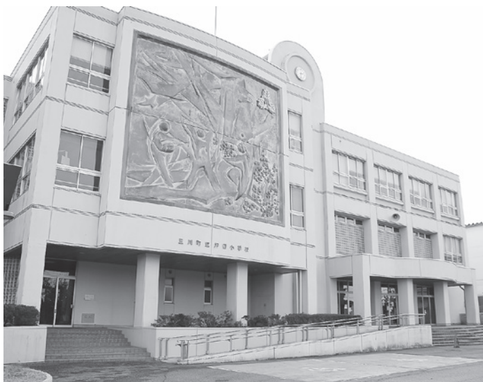
校舎の改修が予定されている押切小学校
