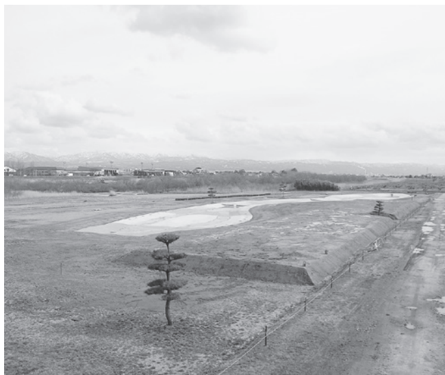
現在工事が進められている田田大橋南側
