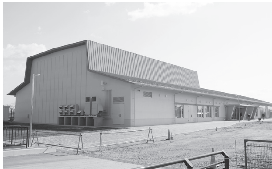
建設中の子育て交流施設「テオトル」
