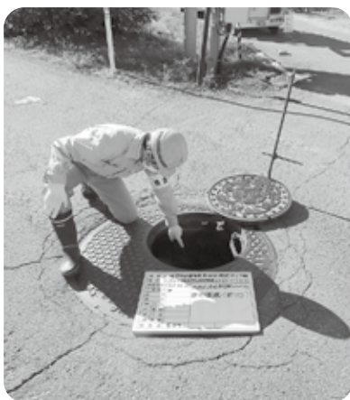
下水道は住民生活に欠かせない重要インフラ
