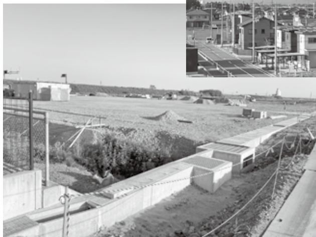
造成中のみかわ産業団地（青山）
