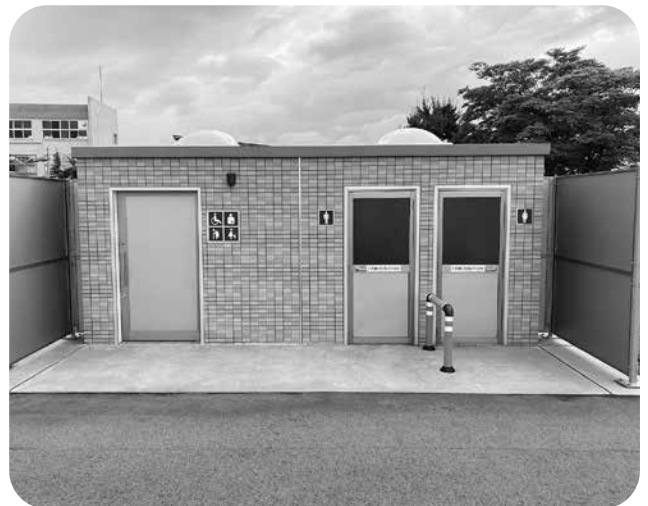
整備された袖東公園のトイレ
