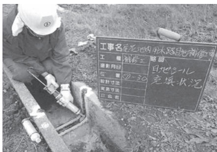
用水路目地補修工事
