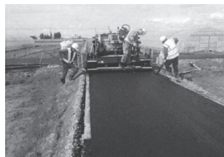
農道舗装工事
