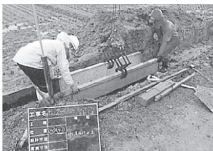
用水路改良工事
