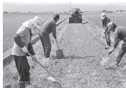
農道補修作業
