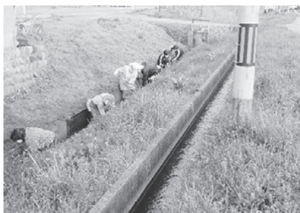
水路の泥上げ作業
